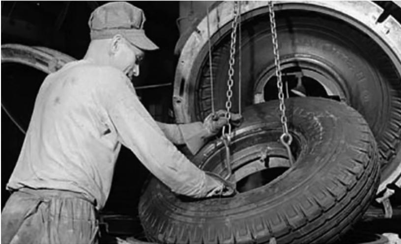
Un ouvrier retire le pneu de caoutchouc synthétique du four de vulcanisation à l'usine Dominion Rubber. (Source photo : Harry Rowed / Office national du film)
